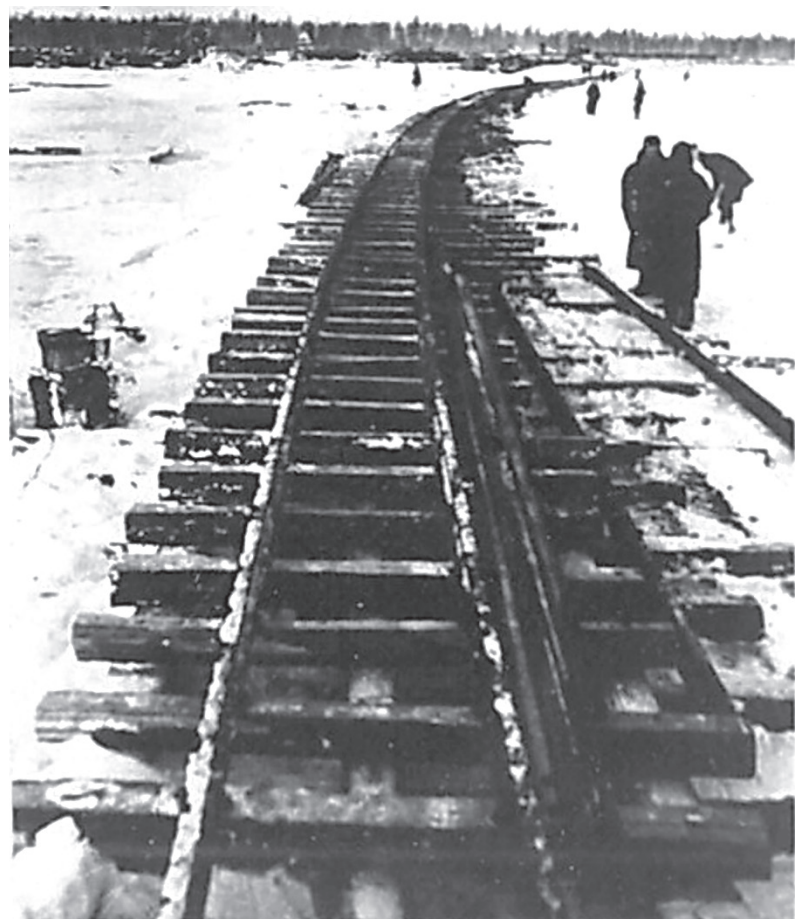
Строительство узкоколейной ж. д. по льду Ладожского озера в декабре 1942 года
